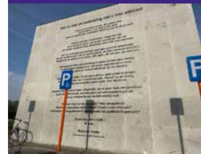
Muur achtergevel CCHasselt
